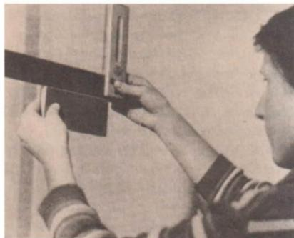
Bild 7 Prüfen eines Werkstückes nach dem Lichtspaltverfahren
