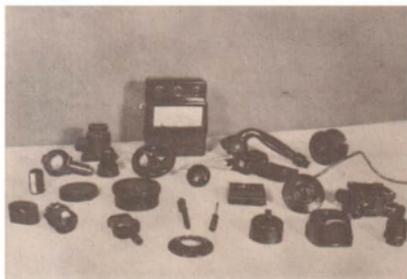
Bild 3 Gegenstände aus Duroplast
