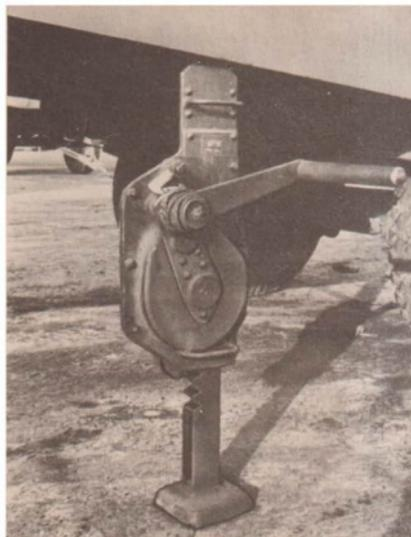
Bild 18 Anheben eines Wagens mit einer Winde
