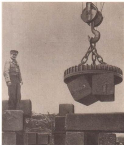
Bild 14 Elektromagnet beim Verladen von Stahlblöcken
