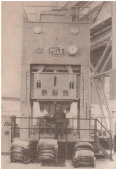
Bild 54 Tiefziehen von Blechteilen an einer Kniehebel-Ziehpresse
