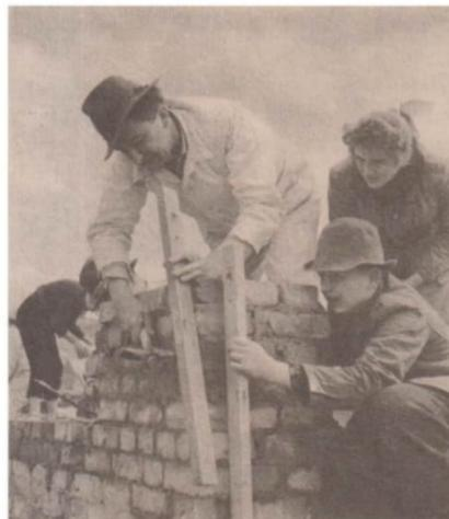
Bild 1 Prüfen mit der Wasserwaage
