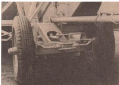
8/1 Hinterachse eines Mähdreschers
