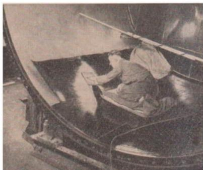
116/1 Auskleiden eines Behälters
