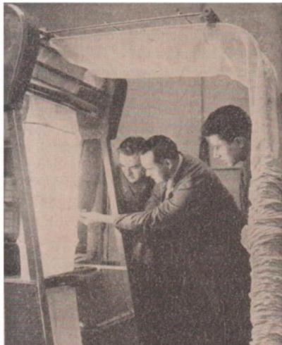
84/3 Prüfen von Maschinengestricken an der Warenschaumaschine
