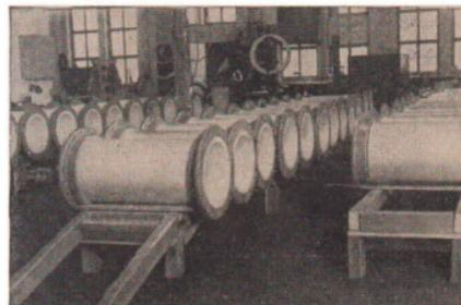
52/1 Porzellanrohre mit aufgekitteten Flanschen
