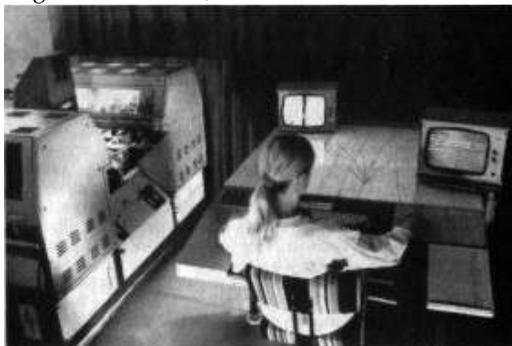
Vermessung von Blasenkammeraufnahmen im Institut für Hochenergiephysik der AdW der DDR am halbautomatischen Meßprojektor HEVAS
