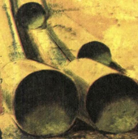
meter Boden mußten die Arbeiter ausheben, 2500 Kubikmeter Felsen des Steilhangs sprengen und hacken. Große Mengen an Material waren zu transportieren, die schweren Wasserleitungsrohre mußten verlegt, ein Hochbehälter und ein Pumpenhaus gebaut werden.
