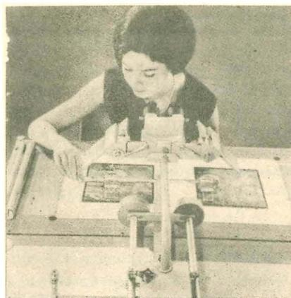
Kartographiefacharbeiterin bei der Auswertung eines Luftbildpaares mit einem einfachen Stereoauswertgerät
