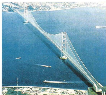
Abb. 5: Die Akashi-Kaikyo-Brücke in Japan, hier eine Computersimulation, wird nach ihrer Fertigstellung 1998 die längste Hängebrücke der Erde sein.
