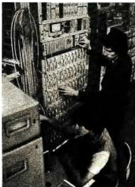
Bild 11/2 Prüf- und Meßarbeiten an einer Fernsprechanlage
