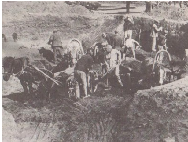
7 Magnitogorsk: Erdarbeiten beim Aufbau eines Martinofens im Jahre 1929
