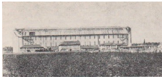
19 Luftschiffhalle in Friedrichshafen
