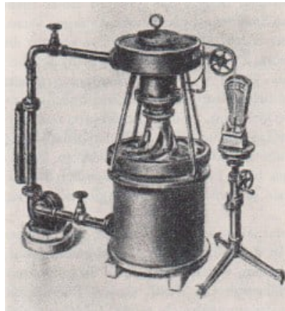
12 Eine von Ackeret 1944 nach Angaben von Euler gebaute Turbine
